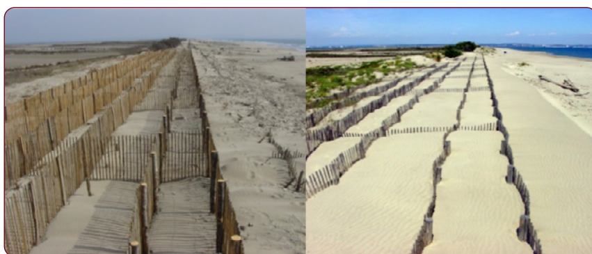
Figure 6.2. Ouvrage de réhabilitation dunaire en Occitanie en 2005 lors de l'installation, puis en 2011 (Source : Hugues Heurtefeux)
